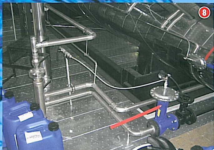
DEFANGATORE TEMPORIZZATO PER 24 ORE DESLIMER WITH TIMER FOR 24 HOURS
