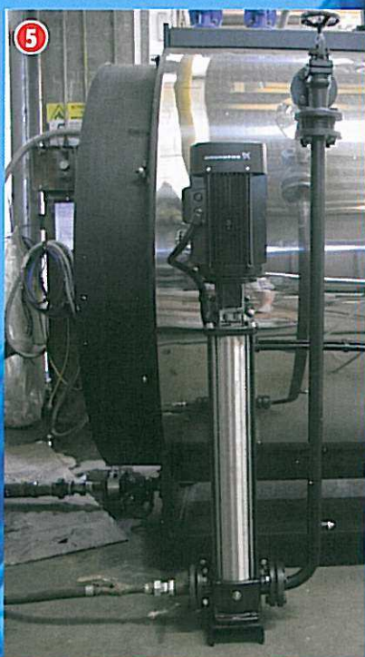
3 GRUPPO ALIMENTAZIONE ACQUA COMPLETO DI POMPA DI VALVOLA DI RITEGNO E VALVOLA A FLUSSO AVVIATO WATER FEEDING PUMP UNIT WITH VALVES
